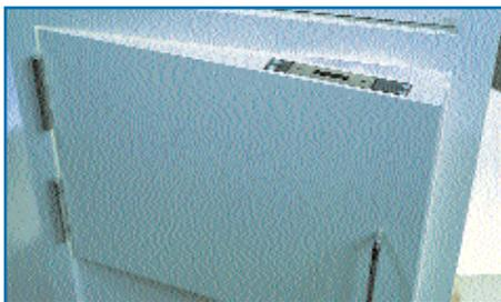
Ces dispositifs sont conçus pour être installés dans l'imposte ou le chambranle d'une porte. La force de rétention attire cette fois la plaque d'armature, permettant à des tétons de positionnement de se placer de la ventouse sur l'armature. Cet ensemble est un mécanisme physique prévu pour contrer une force de cisaillement latérale appliquée à la porte lorsqu'on tente de saboter le verrouillage.
